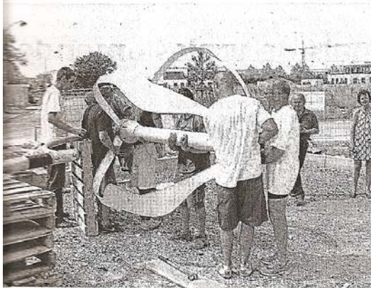
ne en forme de ballon a été installée, hier, à Beaucouzé.
